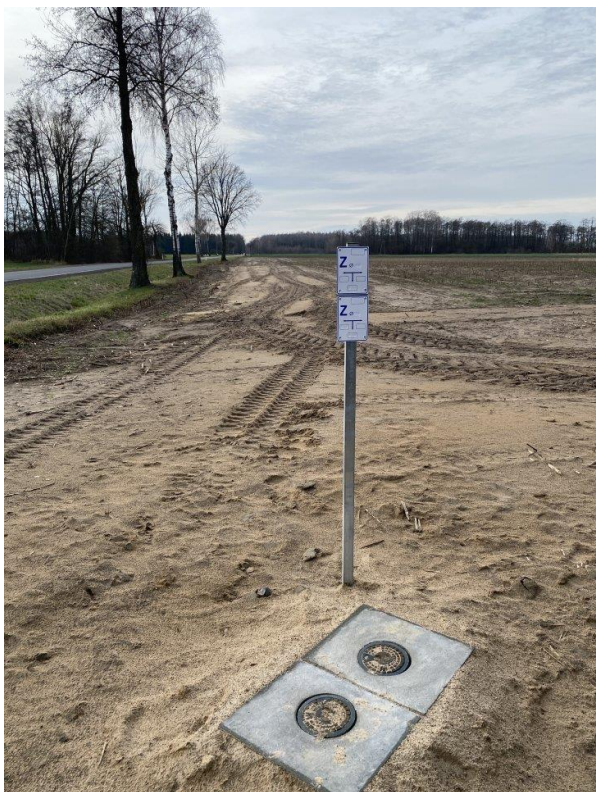
Elementy infrastruktury wodociągowej w miejscowości Kęsy Wypychy
