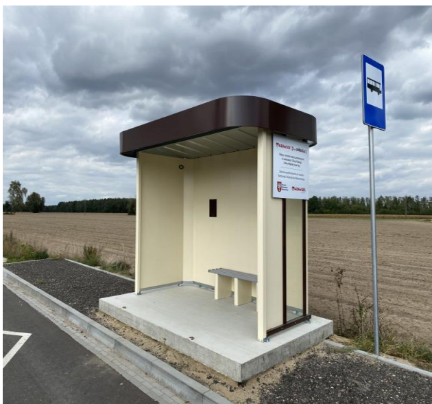
Wiata przystankowa w miejscowości Gzy
